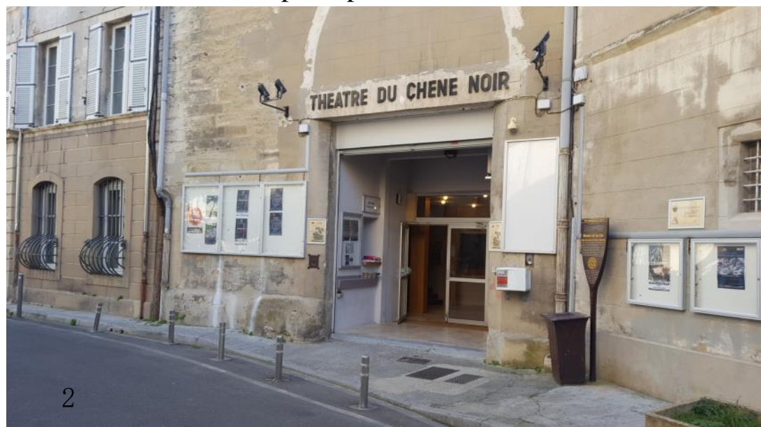
Place de déchargement du Camion
